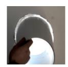
Вставьте телескопический корпус, предварительно отрегулировав его по ширине стены
